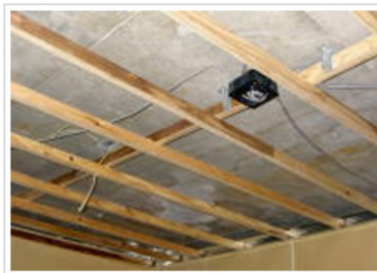
26、天井：軸組完了
