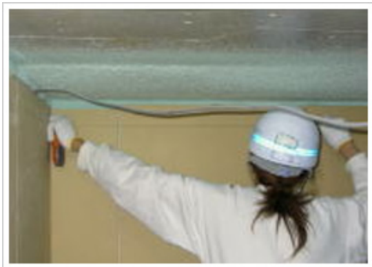
19、天井：天井ライン墨出し
