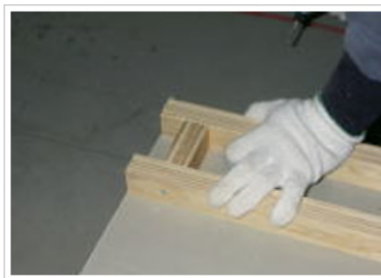
10、入隅：補強組立
