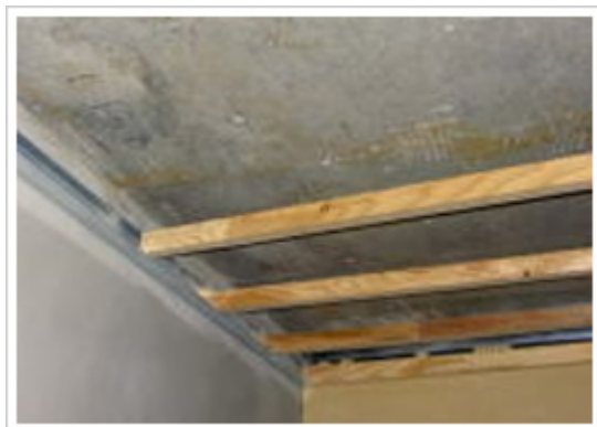
22、天井：野縁取付
