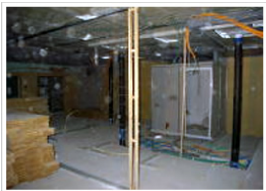
11、入隅：補強立込
